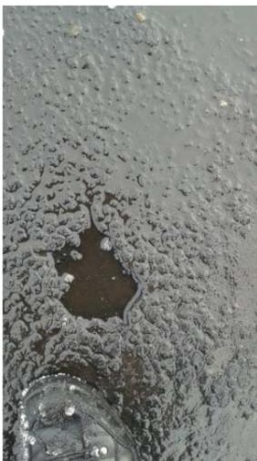
Altersbedingte Undichtheit der Dachpappenfolie (so genannte Elefantenhaut).
